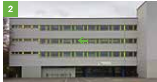
Schulhaus Schwerzi (Sch)
