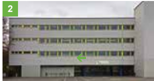
Schulhaus Schwerzi (Sch)
