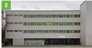
Schulhaus Schwerzi (Sch)
