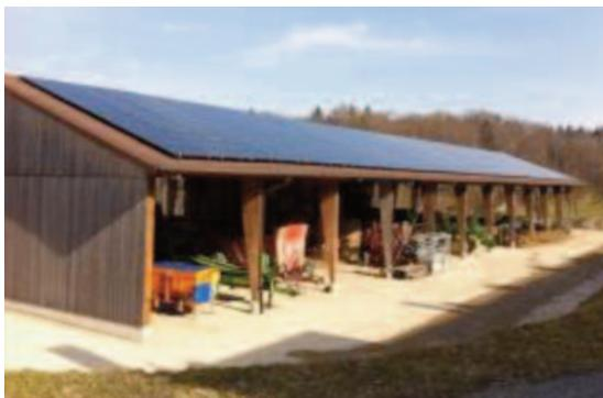
Gut: vollständige Bedeckung mit aufgesetzter Anlage und dem notwendigen Abstand zum Dachrand.
