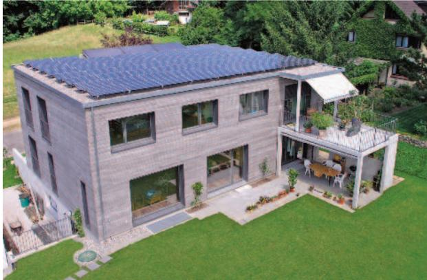
Gut: dem Schema entsprechende Anordnung der Kollektoren auf Flachdach
