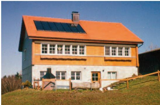
Gut: Anordnung der Kollektoren rechteckig und parallel zu den Dachkanten
