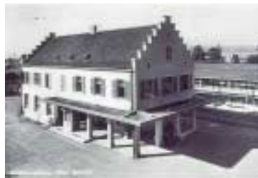
Der ehemalige Bahnhof Pfäffikon.
